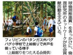
フィリピンのバタンガス州バグバグ小学校で上総掘りで井戸を掘っている様子 (上総掘りをつたえの会提供)
